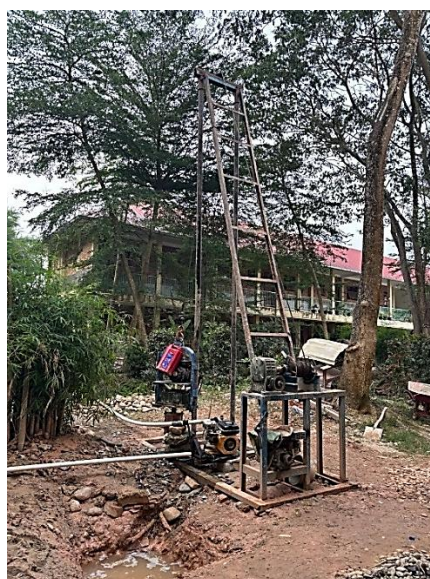
Gambar 2. Pengeboran Sumur Bor
