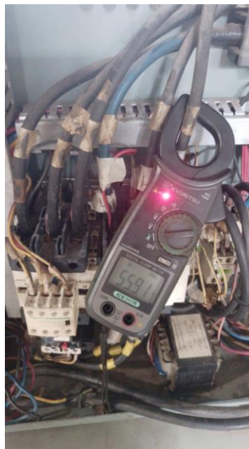
Gambar 6. Hasil pengukuran arus saat commising
